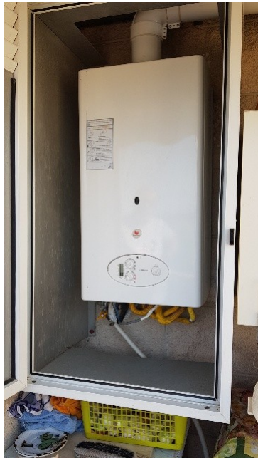
Caldaia esterna "Saunier D. "
